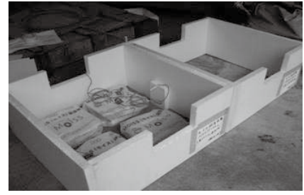
床下・モデル施工試験体
