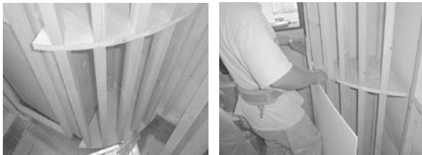
円形柱への施工（下地施工）
