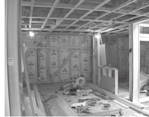
現場での下地配置状況
