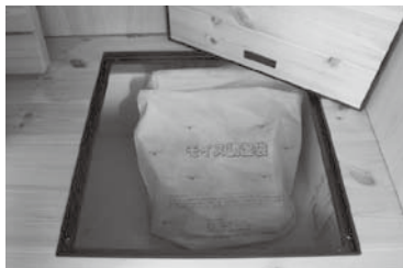
床下への調湿袋の設置の様子
